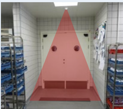
Automatiske kantinedøre med aktiveringssensor placeret i loftet, så den dækker hele gangområdet.
